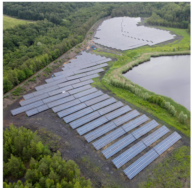
Fertiggestellter PV-Park St. Charles
